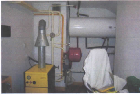
1. PP - technická místnost
