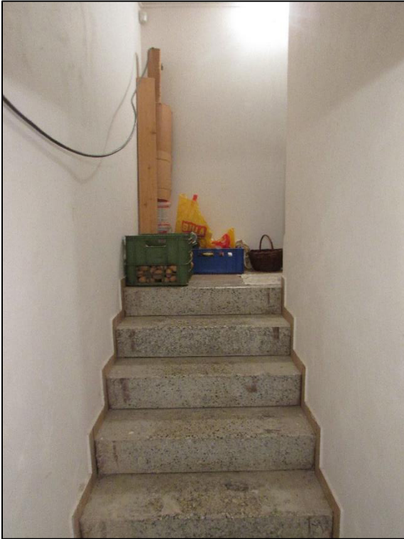
Obr. 5 – Schodiště do 1.PP
