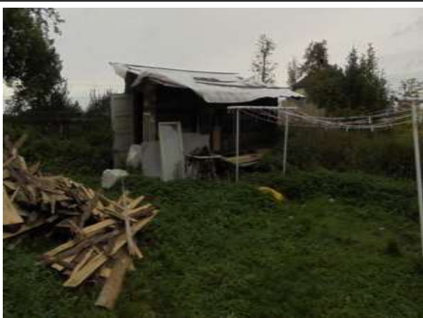
Vedlejší stavba „kůlny“, na p.č. st. 64/2, pohled zvenčí, ze dne 5. 10. 2017
