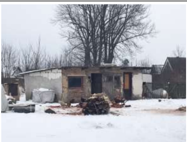
Vedlejší stavba „kůlny“, na p.č. st. 64/1, pohled zvenčí č. 1, ze dne 10. 2. 2018
