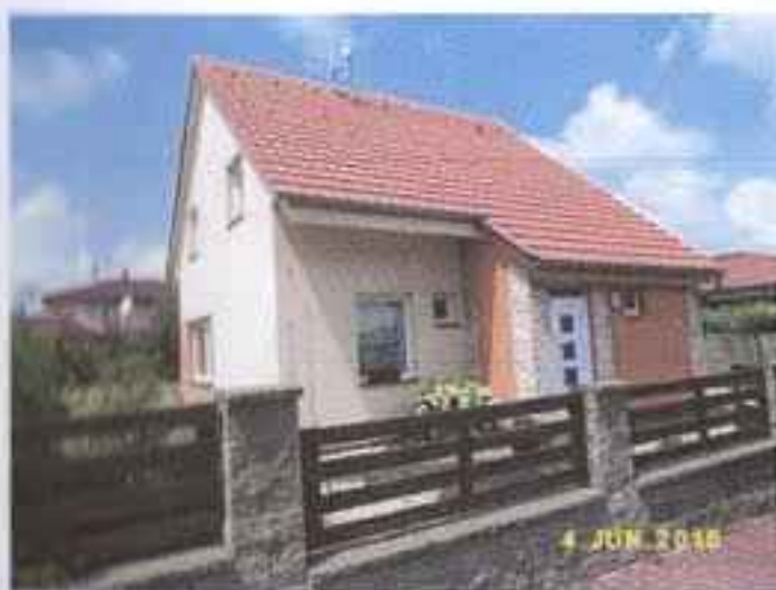
Pohled od příjezdu RD č.p. 282
