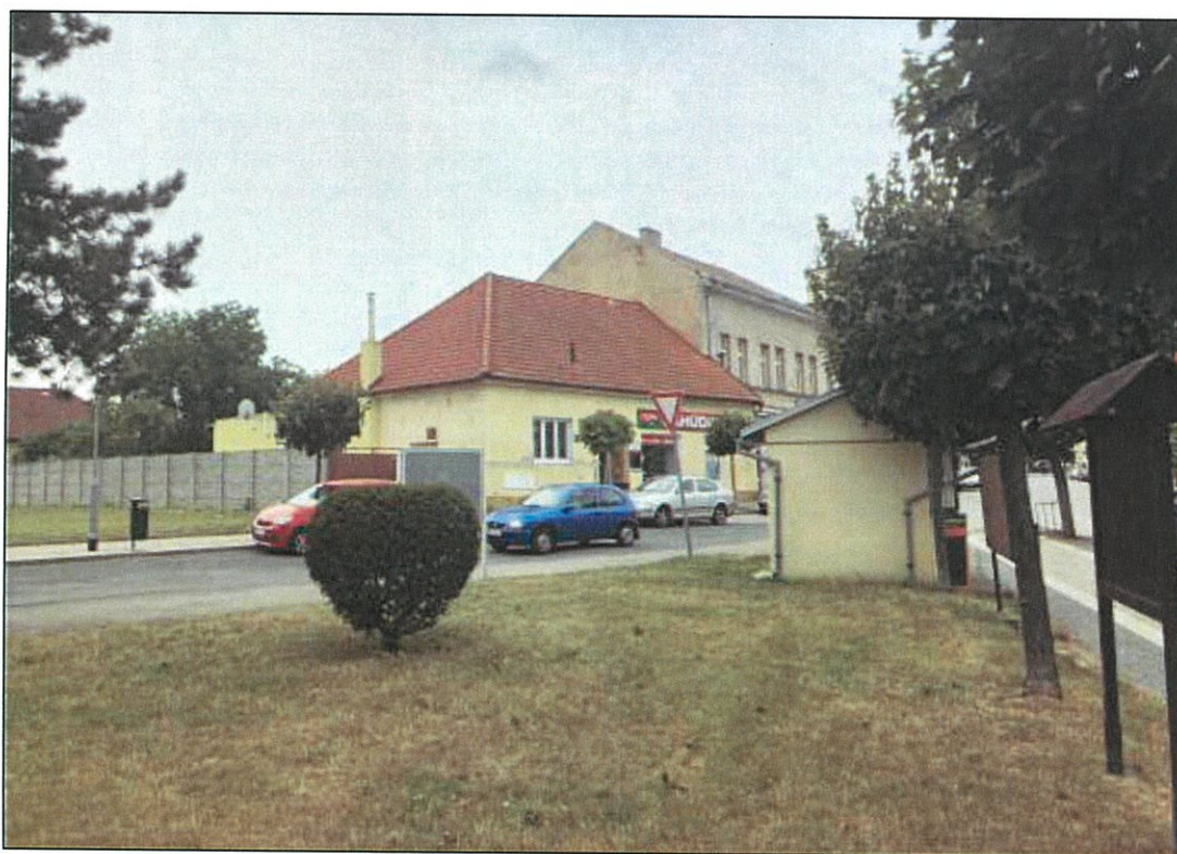
Oplocení objektu z betonových bloků a plechová vrata.
