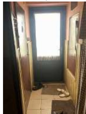
1.NP - vstupní chodba
