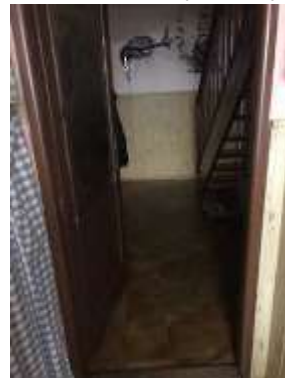
1.NP - vstupní chodba
