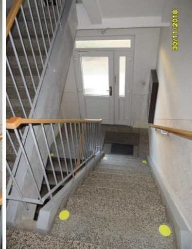
schodiště se vstupem do budovy
