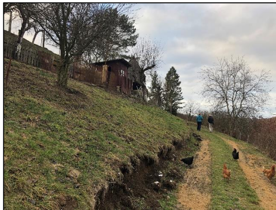
Obr. č. 2 - Příjezdová komunikace na p.č. 283/3
