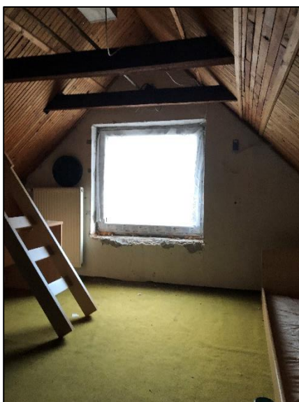
Obr. č. 17 – Stavebně neupravený prostor v 2.NP
