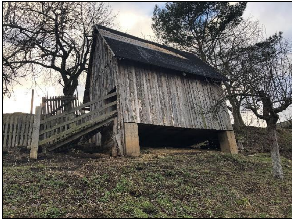
Obr. č. 7 - Příslušenství domu č.p. 36 – zemědělská stavba
