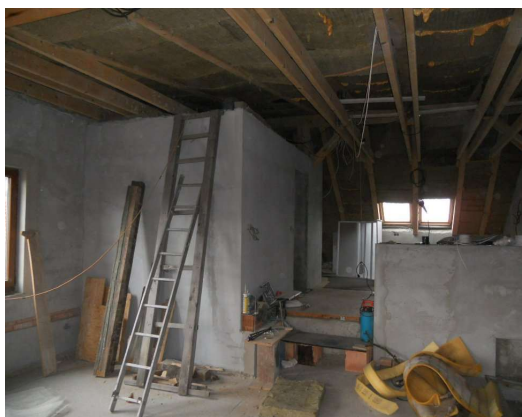
Nedokončené podkrovní místnosti
