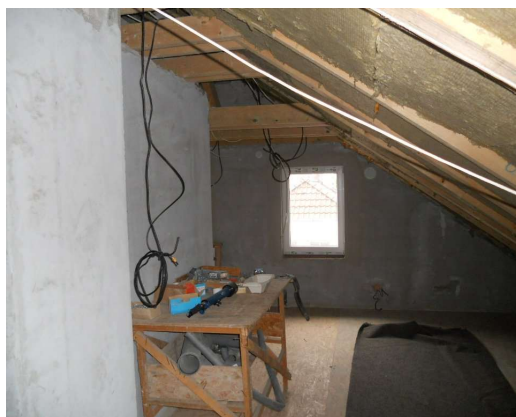
Nedokončené podkrovní místnosti
