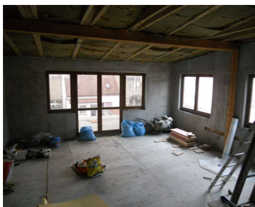
Nedokončené podkrovní místnosti
