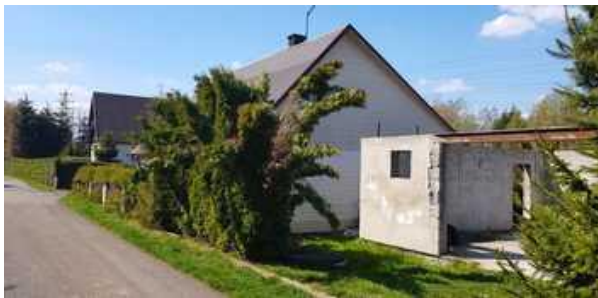
Pohled z ulice (vpravo rozestavěná garáž)
