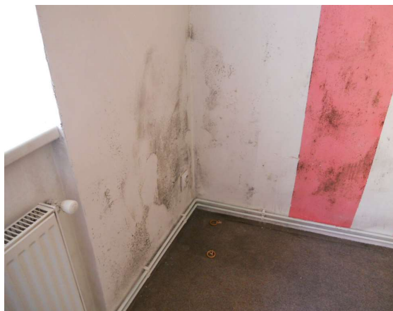
Plíseň tvořící se v 1.NP objektu
