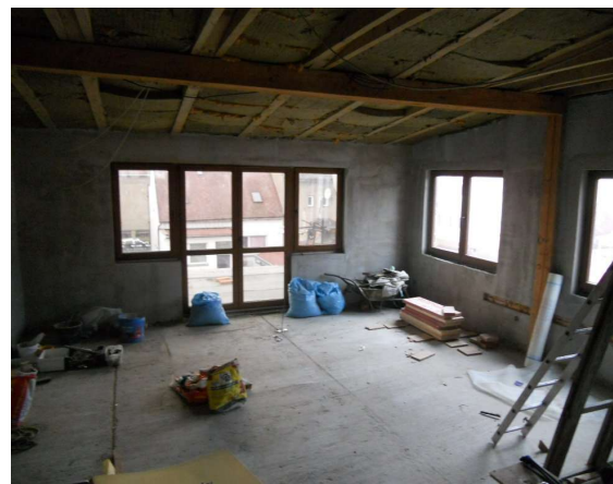
Nedokončené podkrovní místnosti
