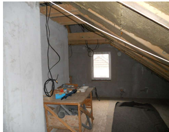
Nedokončené podkrovní místnosti
