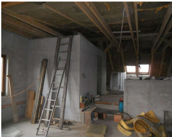
Nedokončené podkrovní místnosti
