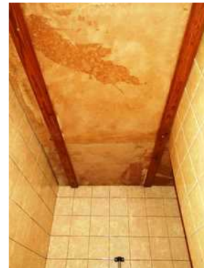
strop v koupelně
