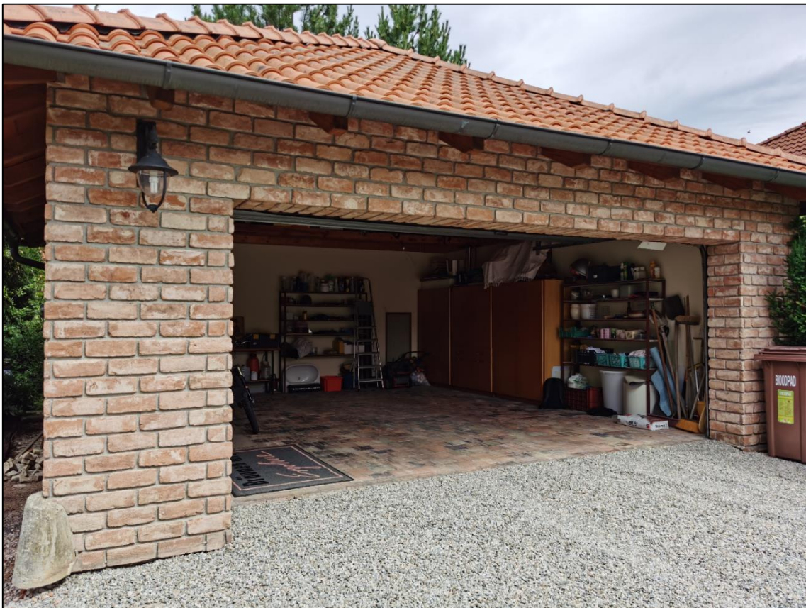
Garáž na parc. č. st. 1186
