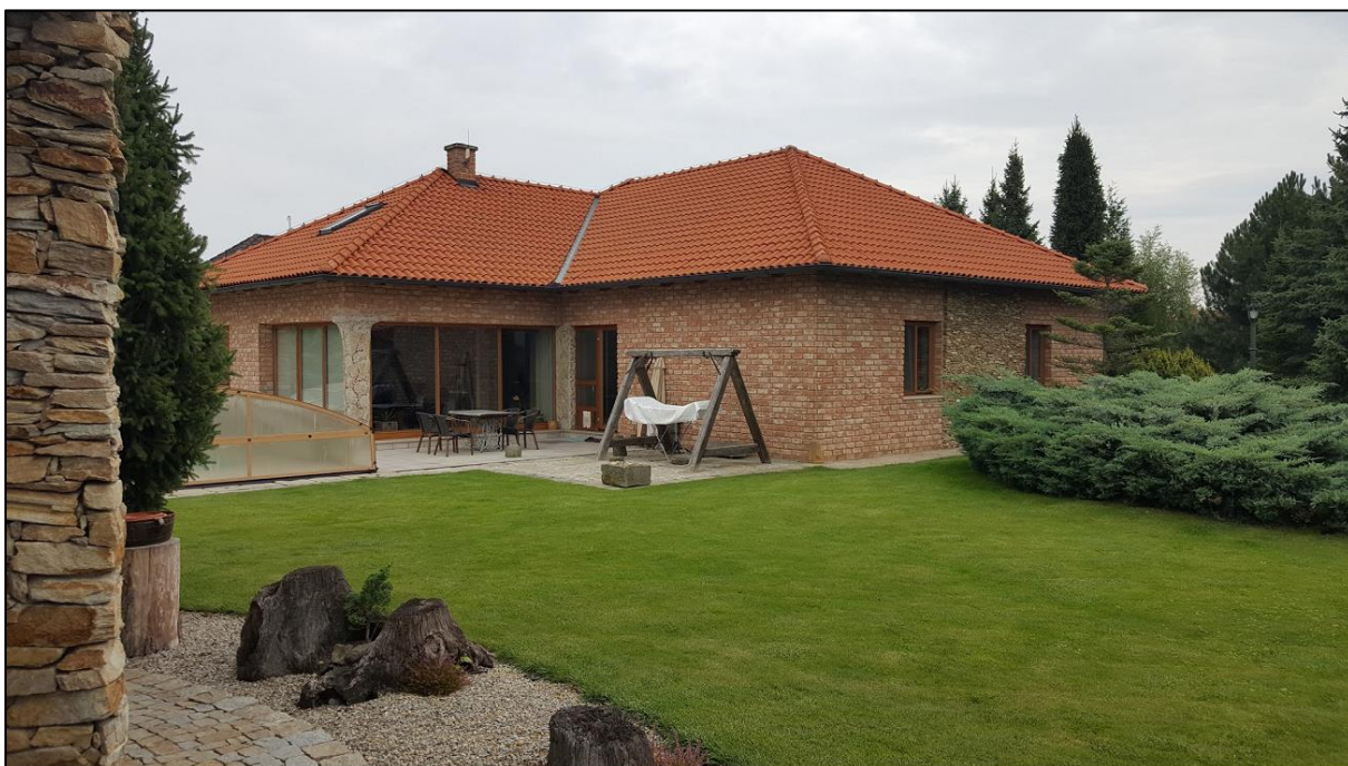
Pohled na RD
