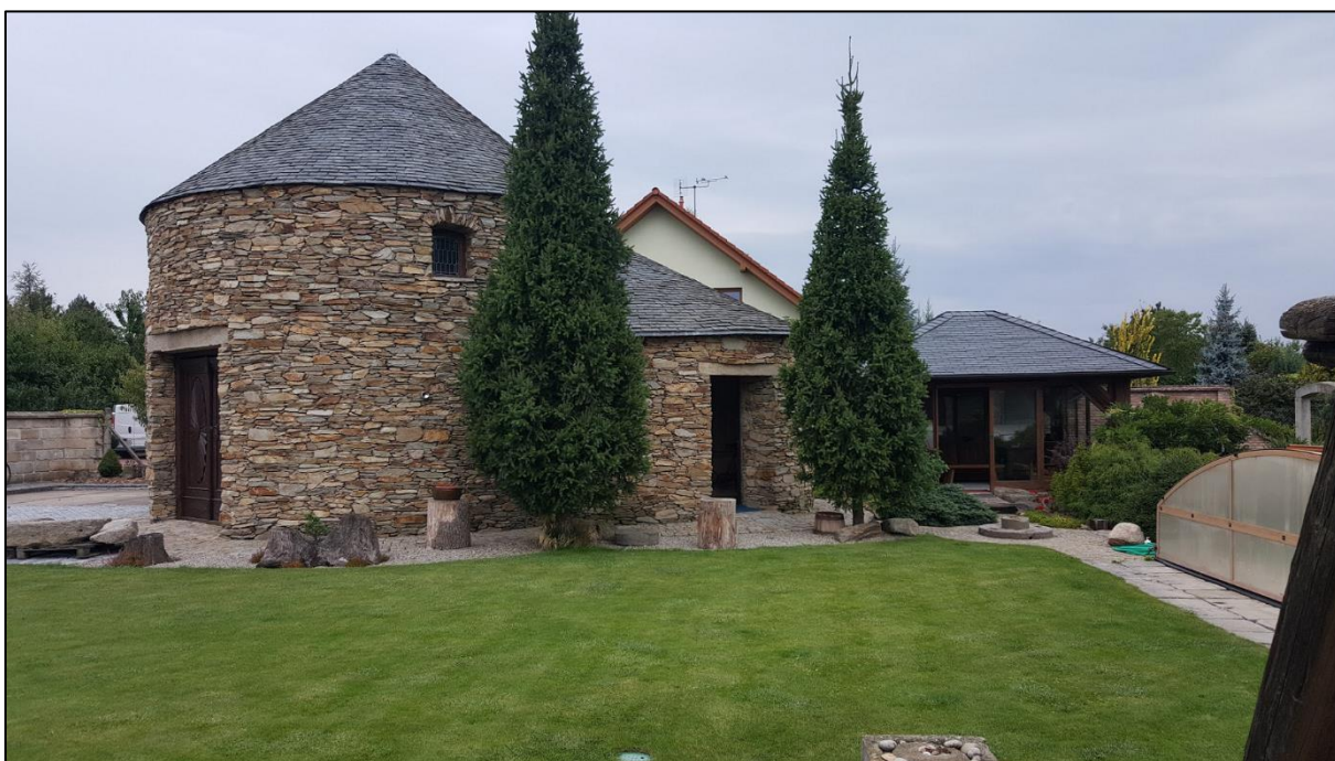
Pohled na rotundu a zasklený přístřešek na parc. č. 319/50
