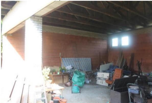
Přístavba navazující na Z štít RD
