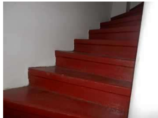
Schody do podkroví
