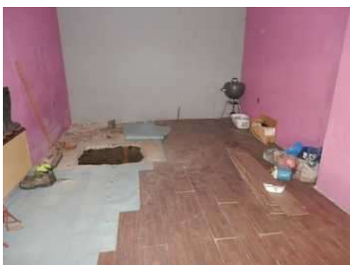
Pokoj (otvor v podlaze)
