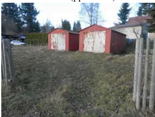
Plechové garáže (ppč.678/9)
