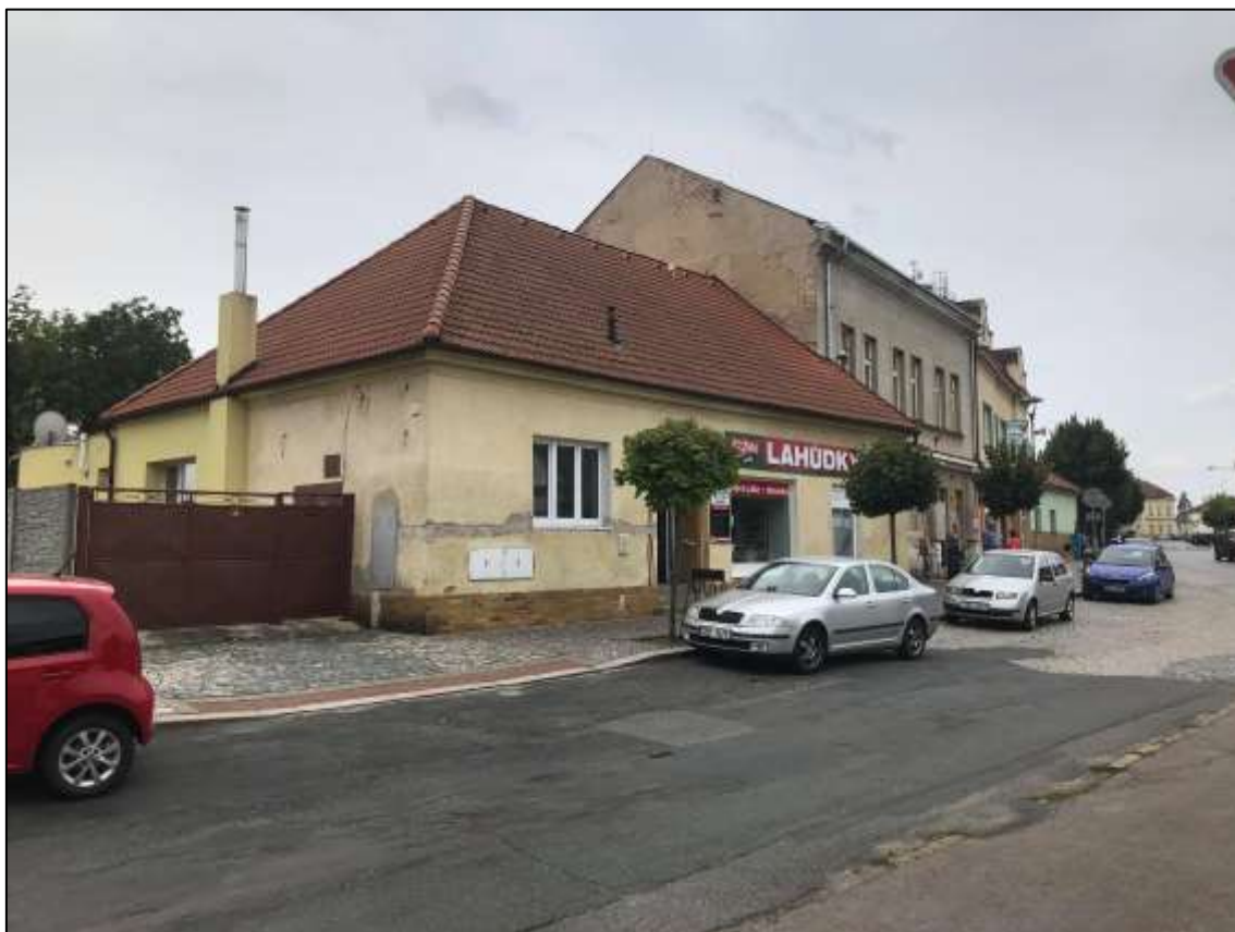
Uliční pohled na oceňovaný objekt.
