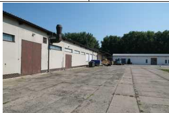
Výrobní a skladové haly
