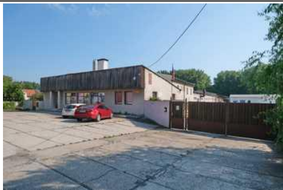
Budova pro obchod a administrativu
