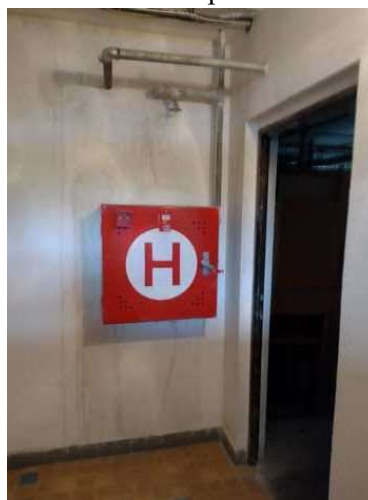
Chodba ke sklepům
