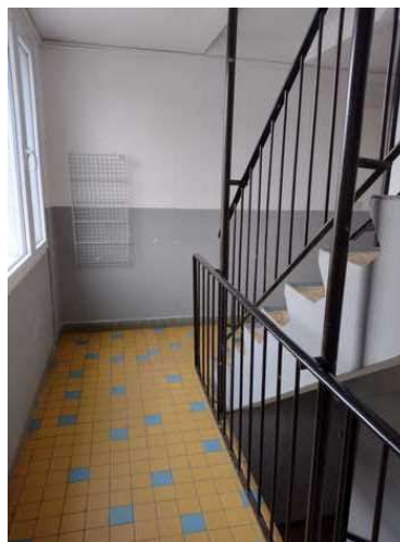
Chodba v přízemí
